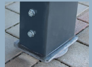
Sichtbarer Anschluss Stütze/Schraubfundament (Flanschplatte Schraubkopf und Stütze über Fahrbahnbelag)
