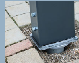
Sichtbarer Anschluss Stütze/Schraubfundament (Flanschplatte Schraubkopf und Stütze über Fahrbahnbelag)
