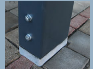
Sichtbarer Anschluss Stütze/Schraubfundament (Flanschplatte Schraubkopf und Stütze über Fahrbahnbelag)
